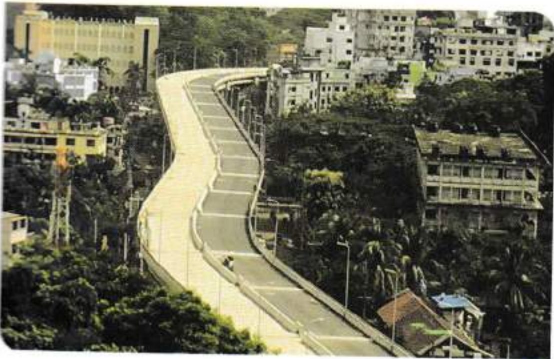
চট্টগ্রাম উন্নয়ন কর্তৃপক্ষ কর্তৃক নির্মিত মুরাদনগর ২নং গেইট ও জিইসি জংশন ব্রাইডজের নির্মাণ প্রকল্প
