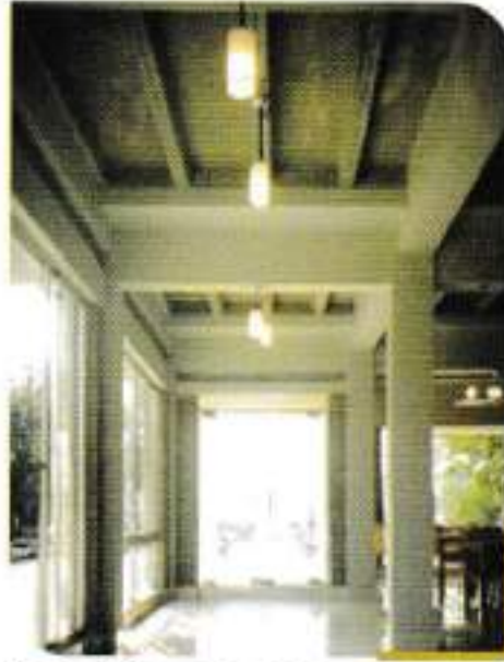
চিত্র ৫: এইচবিআরআই-এর তৃতীয় তলায় সম্প্রসারণকৃত স্থাপনার ফেরোসিমেট চ্যানেল দ্বারা নির্মিত ছাদ।
