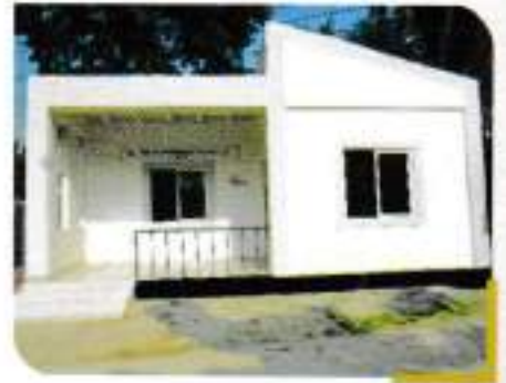
চিত্র-২১। উপকূলীয় এলাকার জন্য স্যান্ড সিমেন্ট হলো ব্লক ও ফেরোসিমেন্ট প্রযুক্তিতে নির্মিত রেজিসিয়েন্ট গৃহ
